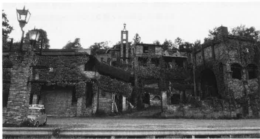
道路から見た全景。喫茶部分が左に続く。 道路から見る。喫茶部分が左に続く
