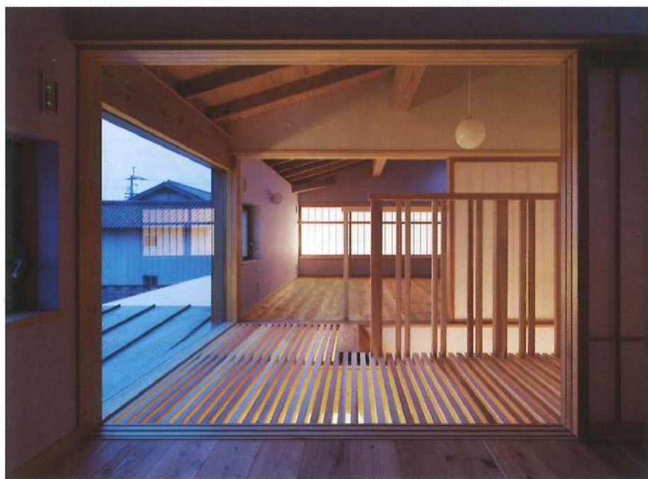
ロフトには透け床を採用。1階への採光の役割も担う。
