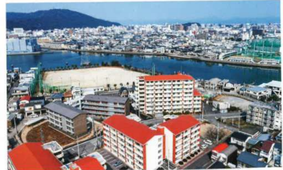
南東斜射影。周辺の既存鉄筋コンクリート造の住棟に対して角度を振って配置し、街並みに動きを与える。
