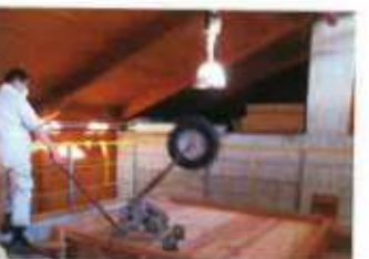
重量床衝撃音試験。検測と試験を重ねて、竣工後の計測では軽重・重量共に性能表示における等級2同等の性能があることを確認。
