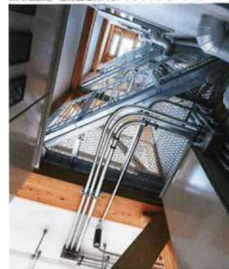
エコシャフト見上げ。浴室や居室に換気・採光を取り入れると共に配管、給湯器を集約しメンテナンスしやすくした。
