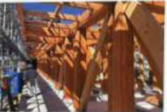
330mm角メインフレームの建て方。1フロアあたり1週間ほどのペースで建て方が進行。
