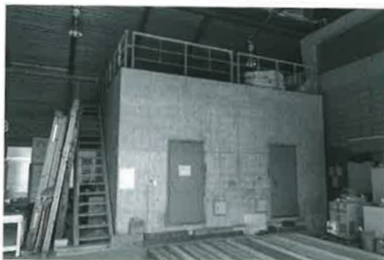
③RC壁式構造の音響測定室
