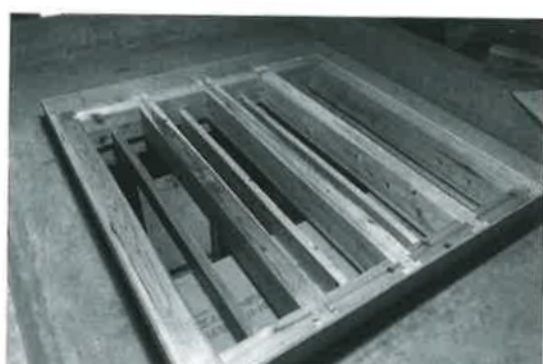
④2階スラブの開口部に施工中の床組み
