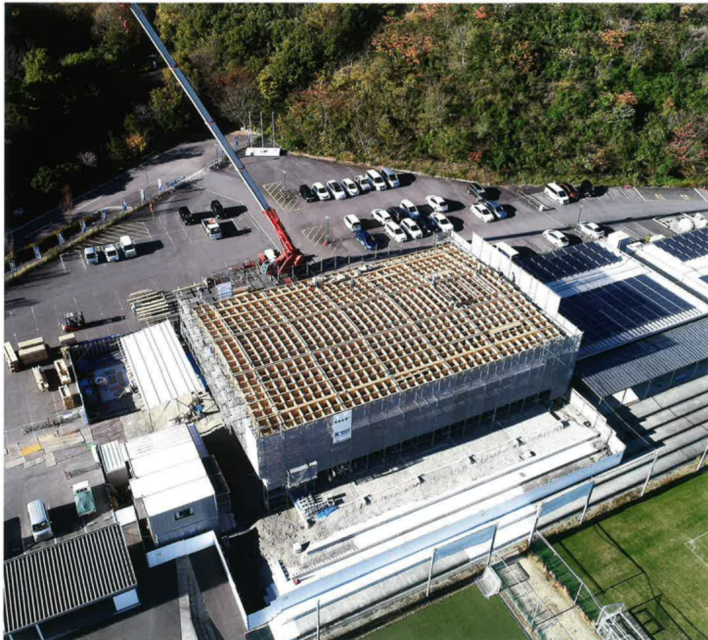
上棟時のドローン写真
