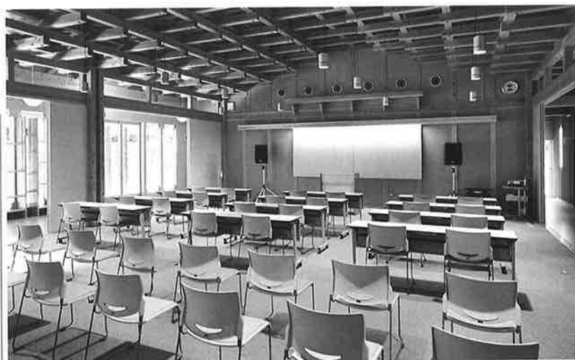
重ね梁による大空間 写真:米津光
