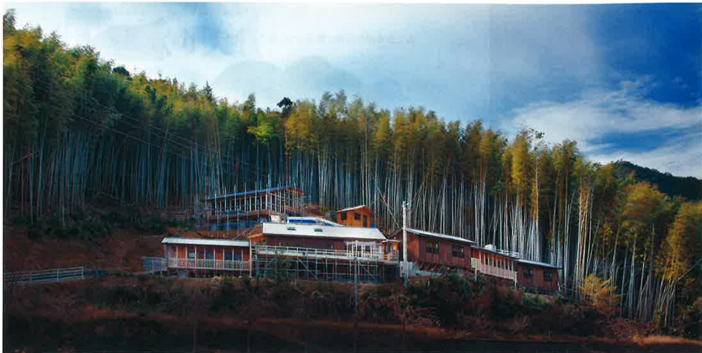
写真4 麓から「このすまい」を望む。連なる方杖による新しい集落の風景。分棟にして道路の湾曲に沿わせている。建物の幅を小さく、基礎はさらに小さく
