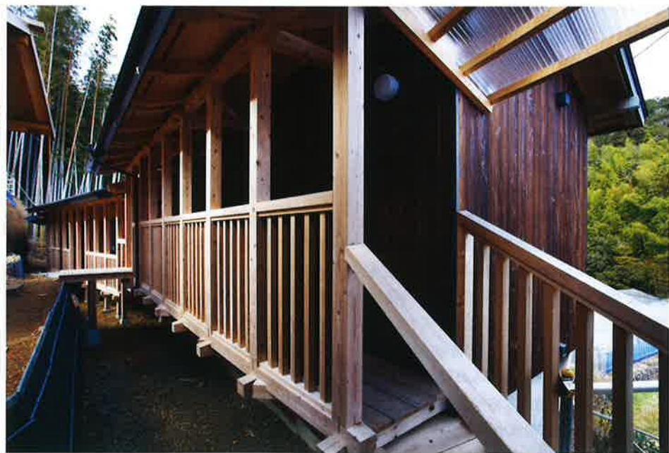
写真6 谷側の軒下空間の連なり
