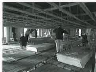
11月29日 足場をおとして下から見上げたら…楽しみです!
