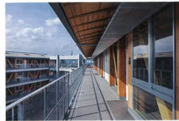
メインフレームを構成する集成材柱は、910mmモジュールをベースに、3,412.5mm(約2間)、2,047.5mm(約1間)で並ぶ
