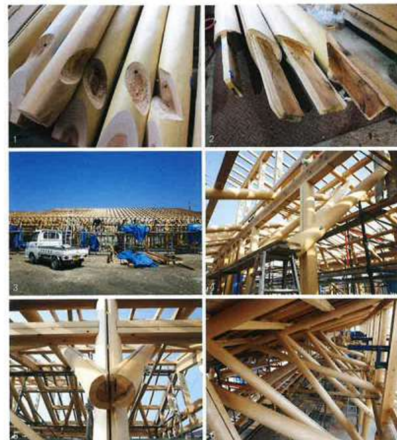
1:挟み方杖。柱とかみ合う部分が欠き込まれている。 2:高窓に向かう長い丸太登り梁に刺さって支える、短い方の登り梁。 3:垂木が載った段階。 4:挟み方杖の間、軒桁に載った丸太登り梁。 5:柱外面より突き出た部分はこの後、垂木に落とされる。 6:高窓部分から見下るす架構。
