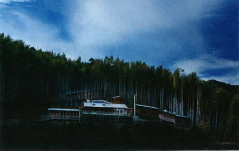
fig.2 「このすまい」 全景。山肌に沿うように建設されている
