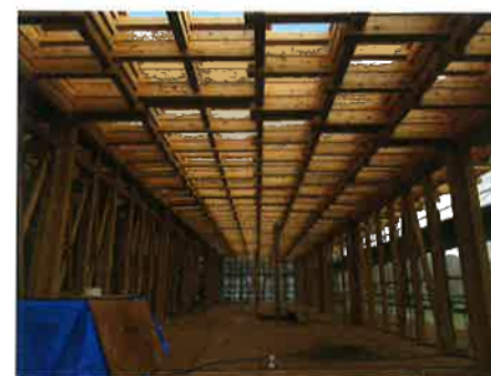
fig.4 ヴォルティスクラブハウスの実際の建て方風景。重ね梁をずらしていき、その傾斜が屋根の勾配となる
