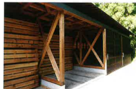
fig.6 完成した備蓄倉庫の備蓄風景 (撮影: 会誌編集委員会)
