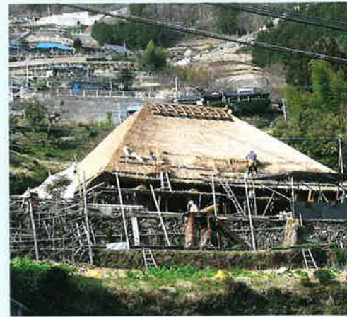
上：茅葺改修中の長岡家住宅。中に入って見学するのも可能
