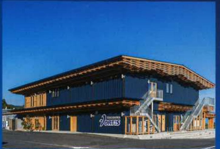
西側外観 妻側には、3スパン分の重ね梁段数の差減が現れている。
